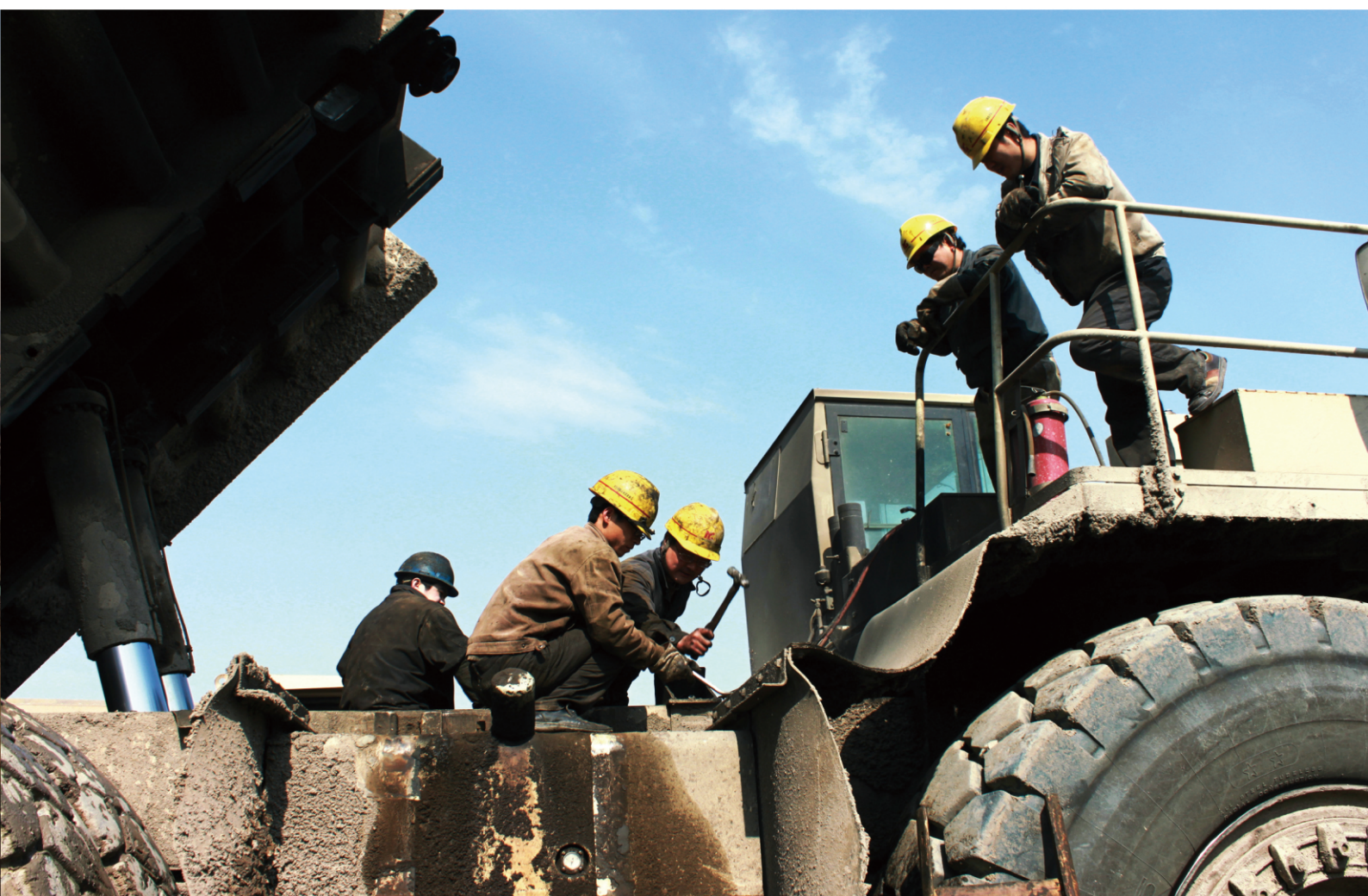
● 南山矿设备维护现场
